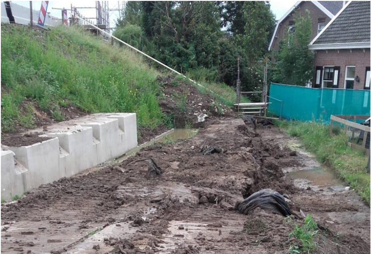
Bovenstaande foto toont dat er voortdurend grondwater naar boven kwam. Het gemiddelde peil van de Lek is hoger dan de waterstand op de foto; ongeveer anderhalve meter hoger dan de polder. Het grondwater stroomde daardoor vanaf hier de polder in. En dat gebeurt dus nog steeds.
