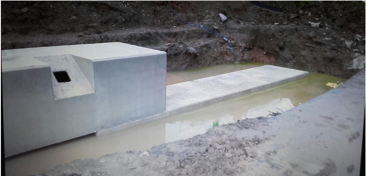
Bovenstaande foto toont dat er voortdurend grondwater naar boven kwam. Het gemiddelde peil van de Lek is hoger dan de waterstand op de foto; ongeveer anderhalve meter hoger dan de polder. Het grondwater stroomde daardoor vanaf hier de polder in. En dat gebeurt dus nog steeds.
