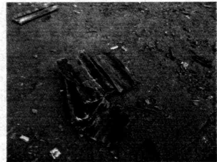
Foto 8: Geknipt staal (kasgoot). Met asbesthoudende kaskit.
